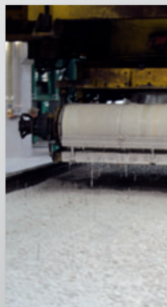
pour the concrete
